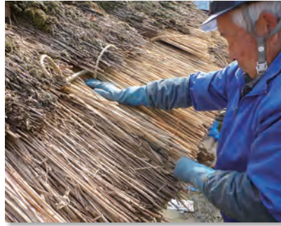
屋根を葺く様子
